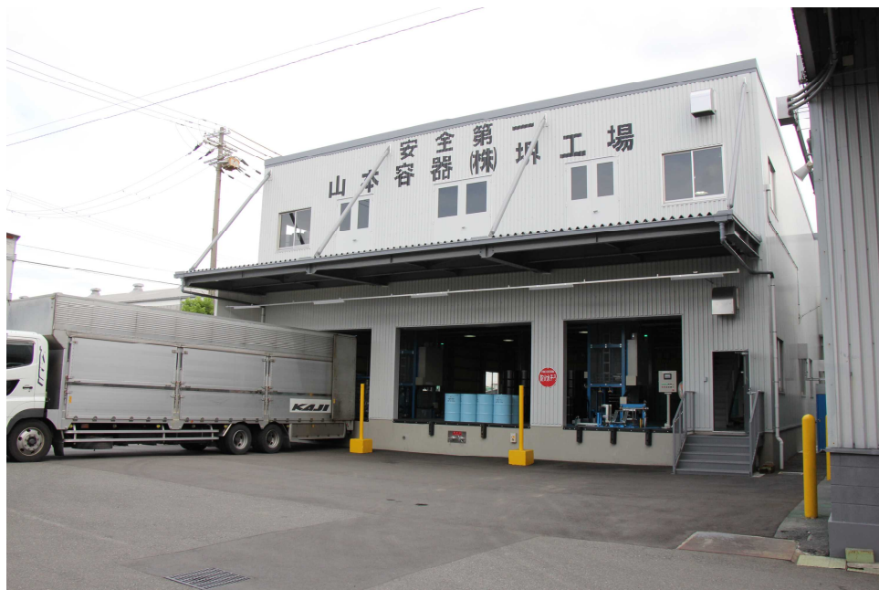
[出荷ヤード棟(鉄骨造2階建)]
